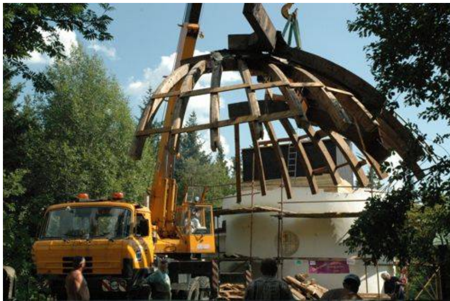
demontáž staré kopule teleskopu KLENOT (červenec 2005)
