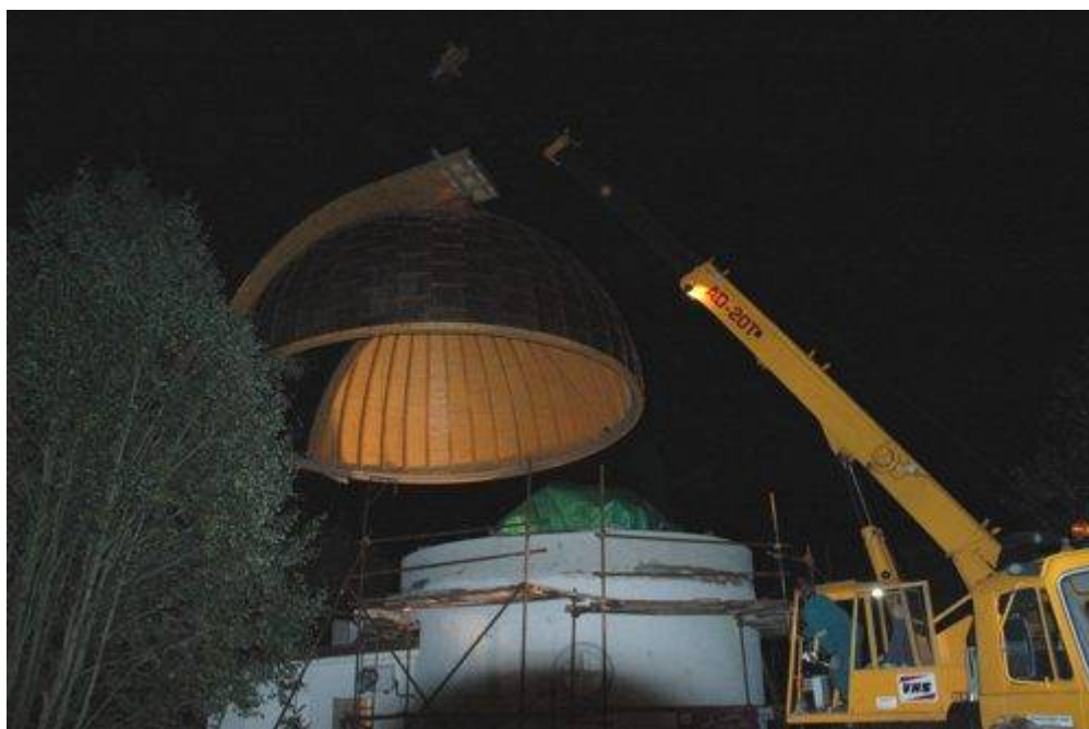
usazování nové kopule teleskopu KLENOT (říjen 2005)
