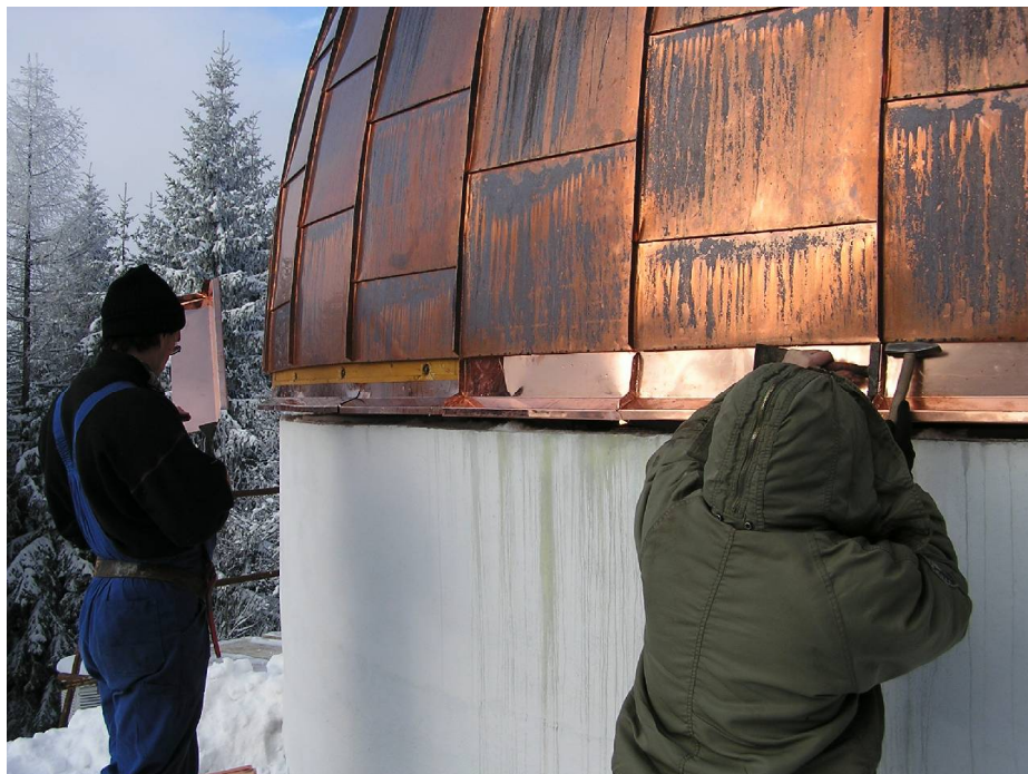
dokončovací práce (listopad-prosinec 2005)
